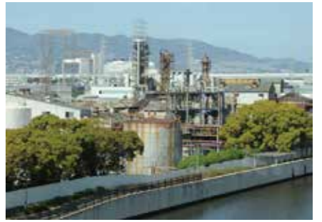
回廊から見る工場風景
